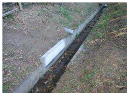
(排水路の補修作業)
