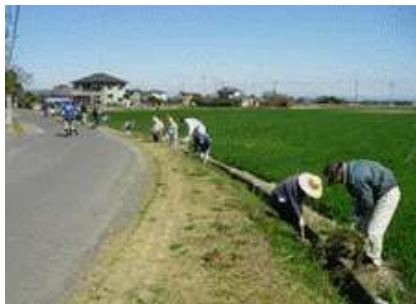
(用水路の泥上げ作業)
