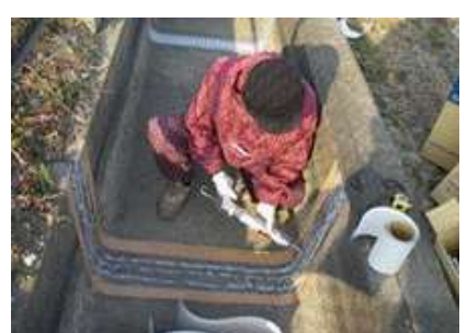
(用水路の目地補修作業)
